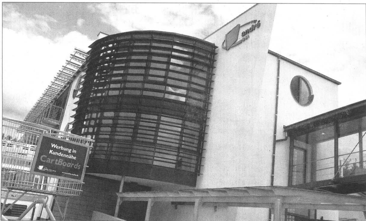
1200 Quadratmeter Platz bietet der Neubau der „andré media group“.
